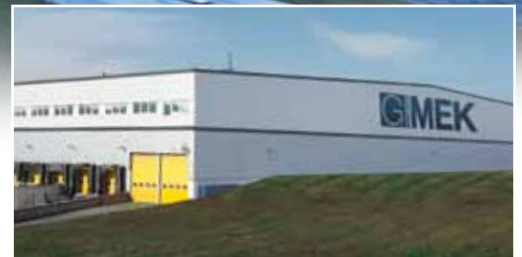
Bátorbágy – HUNGARY (GIMEK Zrt). Production Plant.
